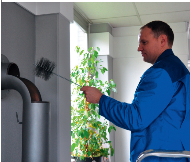
Kehren des Rauchrohrs
